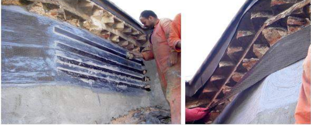
Şekil 4: Kubbe Kasmağında FRP Uygulaması (Küçük Ayasofya Camii, İstanbul) (Güler ve ark., 2004)
