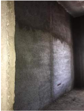
Şekil 11: Çelik Hasır ve Püskürtme Beton Uygulaması
